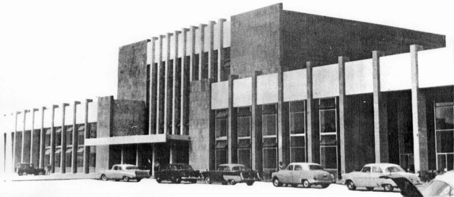
Πρόσψη κεντρικό τμήματος.— Facade on main building.— Fa- cade du département central. — Vorderseite des zentralen Traktes
