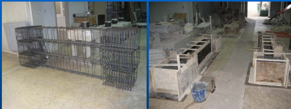
Φάσεις κατασκευής δοκιμών κλίμακας 1:1
