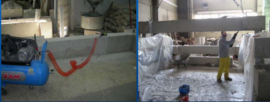
Φάσεις κατασκευής δοκιμίων κλίμακας 1:1
