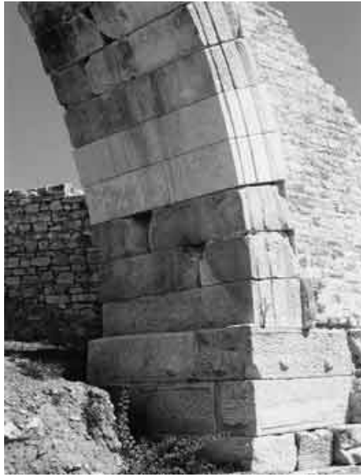
Εικ.:Το μεγάλο τόξο αντιστήριξης μετά τις αναστηλωτικές εργασίες.
