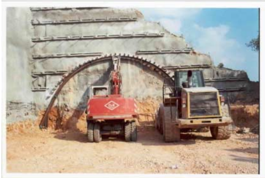
Μετωπικός πασσαλότοιχος στο δυτικό στόμιο της σιδ/κής σήραγγας ΣΣ3 Κακιά Σκάλα
