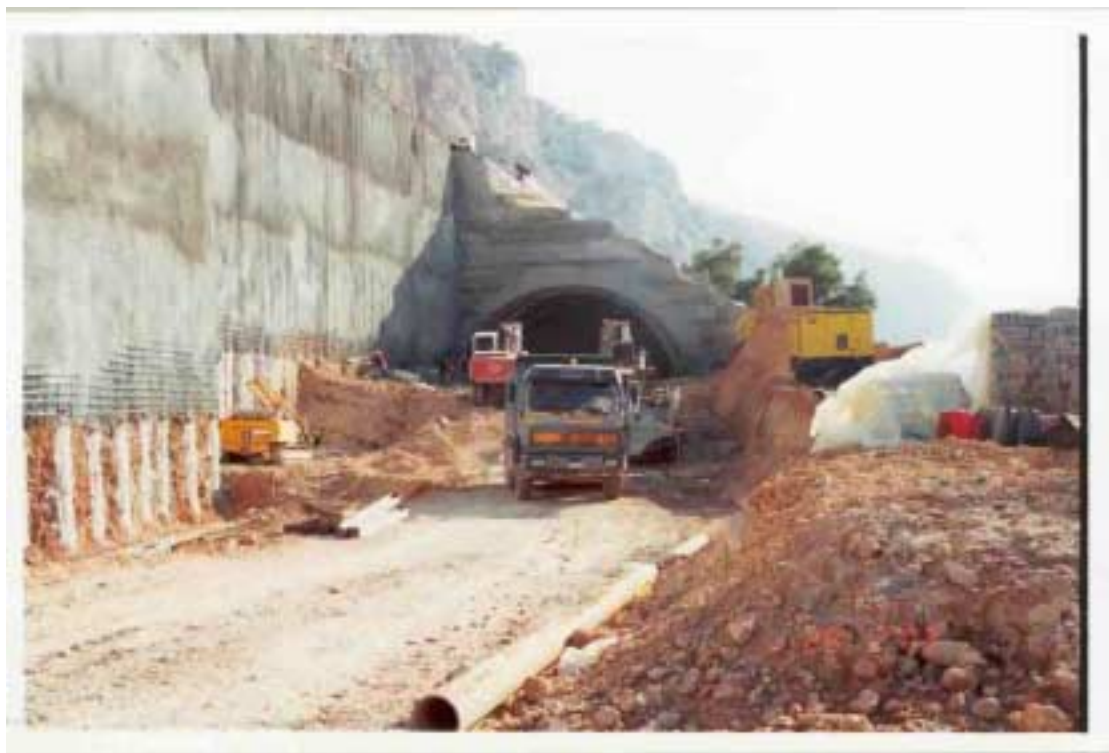
Πασσαλότοιχοι στο δυτικό στόμιο σιδ/κής σήραγγας ΣΣ3 Κακιά Σκάλα
