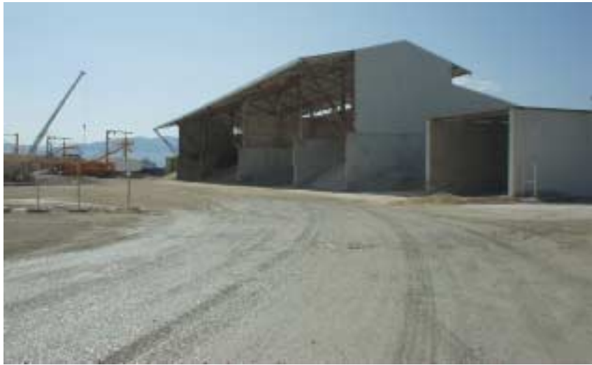
Φωτογραφία 1. Χώρος αποθήκευσης αδρανών
