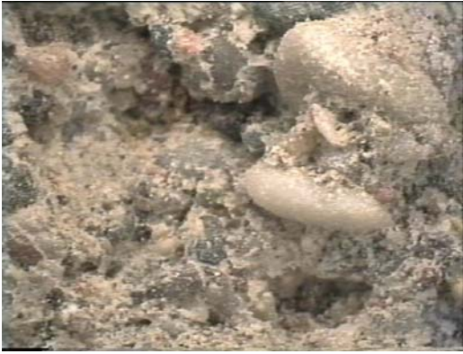
Εικόνα 13: Επιφάνεια σκυροδέματος x25 του κτιρίου Ροτόντας
