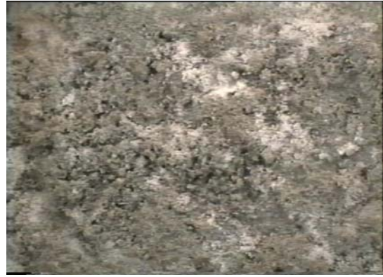
Εικόνα 14: Επιφάνεια gunite x25 του κτιρίου Τρούλου
