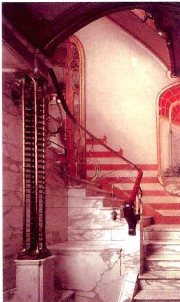
Εικ. 7. Χάλκινο σώμα με αξονικό θερμοφόρο σωλήνα, σε πολυτελή κατοικία των Βρυξελών, 1898 (Αρχιτέκτων V. Horta, φωτ. R. Lautwein).
