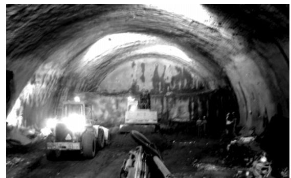
Σχήμα 7 Τμηματική διάνοιξη της αίθουσας του σταθμού Figure 7 Tunnelling the station in stages.
