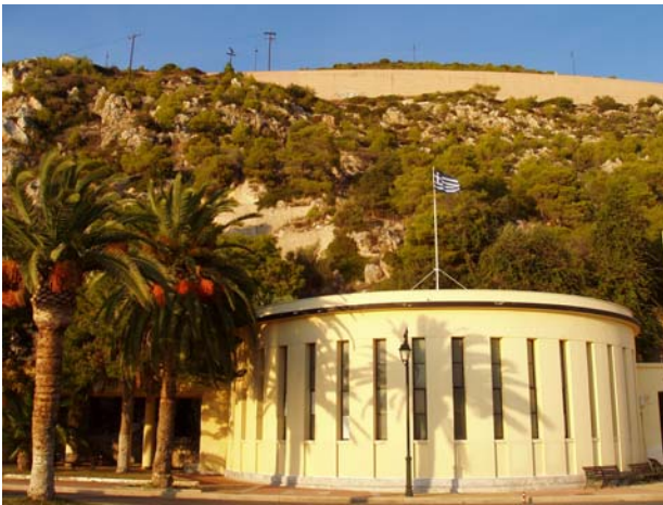
Φωτογραφία 2. Άποψη του ανατολικού πρानούς ανάντη του κτιρίου ιαματικών πηγών Photograph 2. View of the east slope above the thermal springs building.
