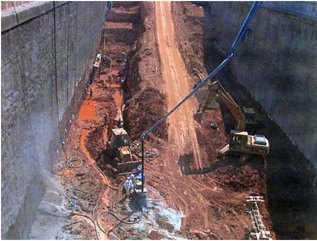
Φωτογραφία 1. Αποψη της εκσκαφής για το Σταθμό “Χαλάνδρι” Photograph 1. View of “Halandri” Station excavation site
