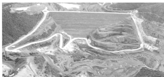
Φωτογραφία 2. Κατάντη άποψη φράγματος. Photograph 2. Downstream view of the dam.
