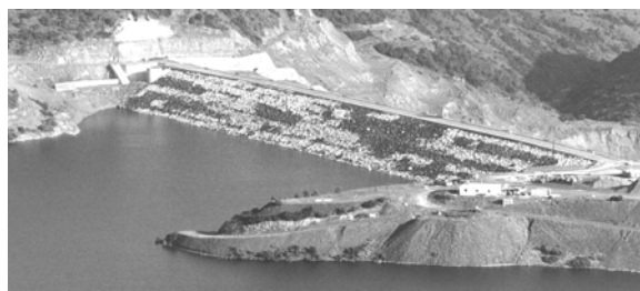
Φωτογραφία 1. Ανάντη άποψη φράγματος. Photograph 1. Upstream view of the dam.
