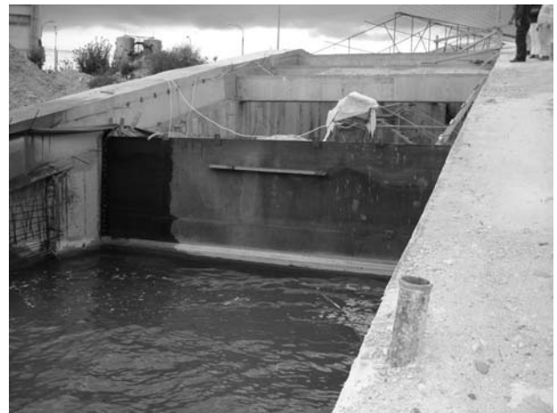
Φωτογραφίες 4. Ανάντη άποψη προσωρινού φράγματος.
