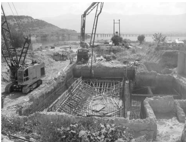
Φωτογραφία 1. Άποψη Αντλιοστασίου κατά την κατασκευή. Photograph 1. Pumping Station view during construction.
