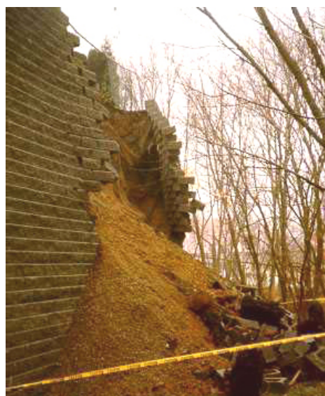
Φωτογραφία 1. Άποψη του τμήματος της πρώτης αστοχίας Photograph 1. First failure of the wall
