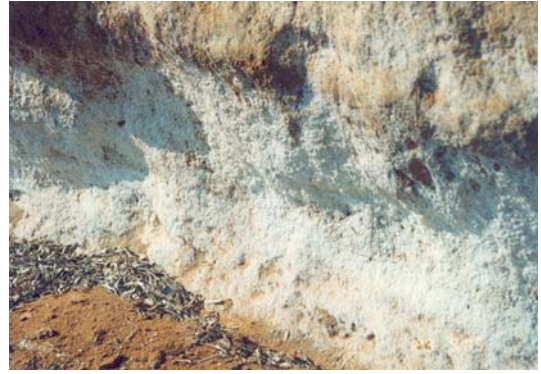
Φωτο 10. Συγκέντρωση αλάτων στην επιφάνεια του πρανούς. Photo 10. Salt concentration on the surface of the cliff
