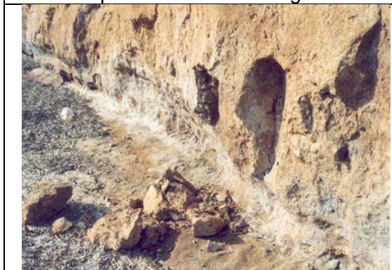
Φωτο 2. Υποσκαφή πρανούς και αστοχία ολόκληρου του πρανούς. Διακρίνονται τα επίπεδα αποχωρισμού των πλακών των εδάφους. Εδάφη χαμηλής αντοχής Photo 2. Cliff undercut and failure of the whole slope. Soils of low strength
