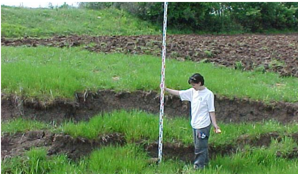
Φωτογραφία 4. Άποψη της αστοχίας στα Κόμαρα. Ανύψωση του φυσικού εδάφους στον πόδα της αστοχίας περί το 1.5 m. Photo 4. View of the landslide at Komara. The vertical heave of the slide's toe was about 1.5 m.
