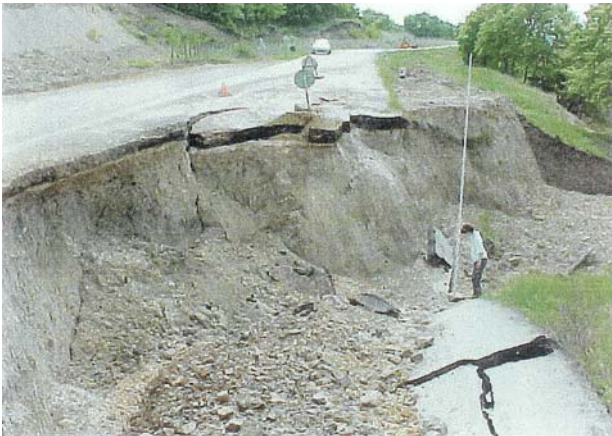
Φωτογραφία 2. Άποψη της αστοχίας στη Δοξίπαρα. Το ύψος του καθρέπτη ολίσθησης ανέρχεται σε 3.0 m Photo 2. View of the landslide at Doksipara. The height of the (vertical) head is 3.0 m.
