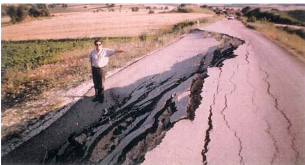
Σχήμα 6. Γεωτεχνική τομή πρσανούς ολίσθησης στη Χελιδόνα.
