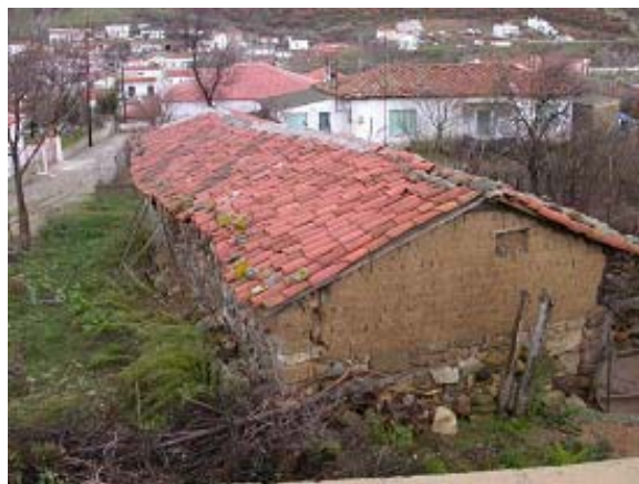
Εικ. 4. Γεωμετρικές παραμορφώσεις και βλάβες κτιρίου από ευτελή υλικά.
