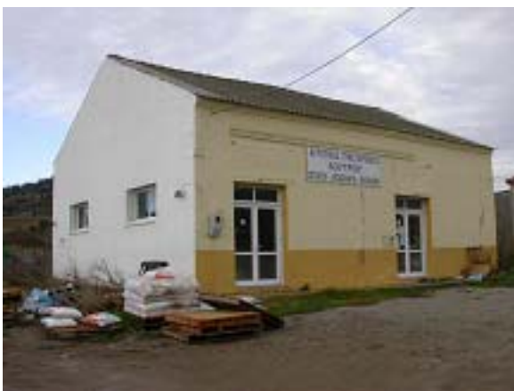
Εικ. 11. Κτίριο Αγροτικού Συνεταιρισμού Λουτρού.
