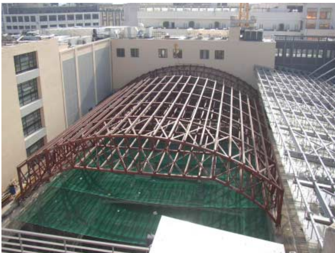
Εικόνα 10. Φάση συναρμολόγησης νέας μεταλλικής Στέγης
