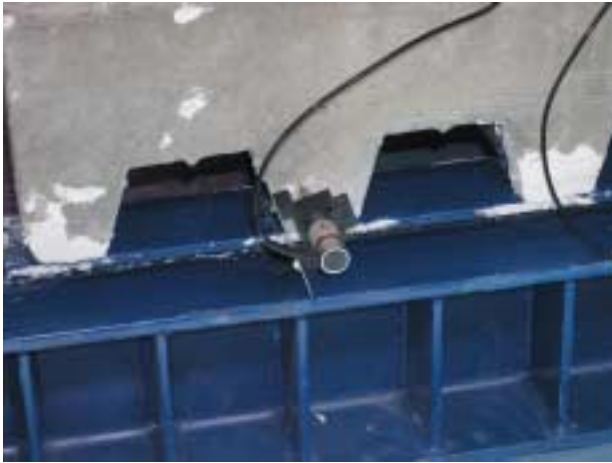
Εικόνα 2. Διάταξη μηχανομητρώων (A, B, C, D) προσδιορισμού οριζόντιας ολίσθησης στη πλάκα στις στηρίξεις της πλάκας.
