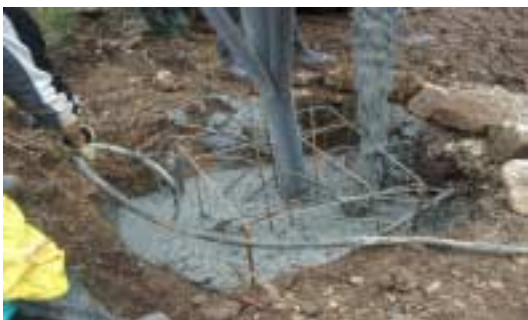
Φωτ. 7. Διαδικασία σκυροδέτησης πύργου.
