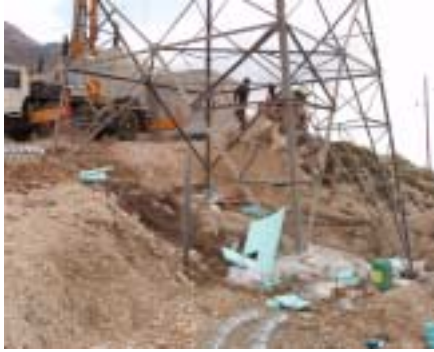
Φωτ. 17. Εργασίες ανέγερσης πύργων μετά την πάροδο των τριών ημερών από την ημερομηνία σκυροδέτησης των βάσεων θεμελίωσης.
