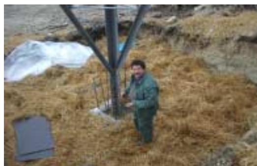
Φωτ. 10. Θερμομονωτική προστασία του σκυροδέματος βάσεων θεμελίωσης πύργων.
