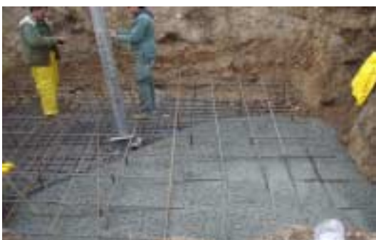
Φωτ. 9. Διαδικασία σκυροδέτησης πύργου.
