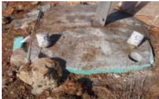
Φωτ. 13. Πυρηνοληψίες σε βάση θεμελίωσης πύργου.
