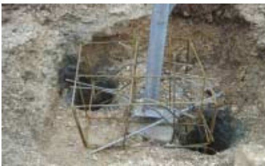
Φωτ. 5. Τοποθέτηση σιδηρού οπλισμού σε βάση πύργου.
