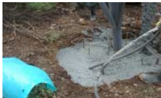
Φωτ. 8. Διαδικασία σκυροδέτησης πύργου.
