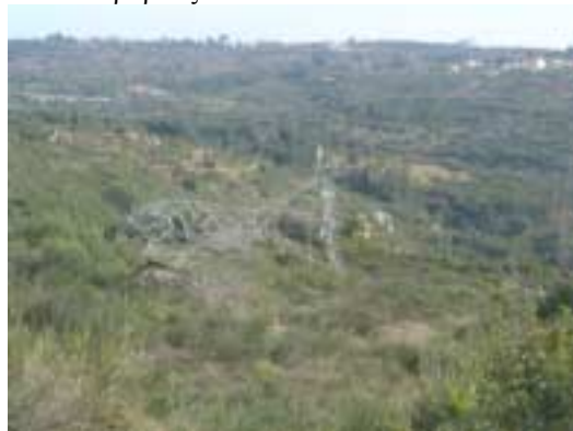
Φωτ. 2. Πολλαπλασιασμός της επιφάνειας προσβολής από τους ανέμους λόγω του πάγου και υπερβολική αύξηση του βάρους του.
