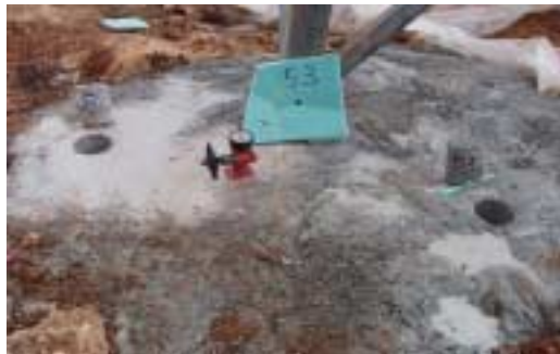
Φωτ. 14. Πυρηνοληψίες και εκτέλεση δοκιμής εξόλκευσης ήλου.
