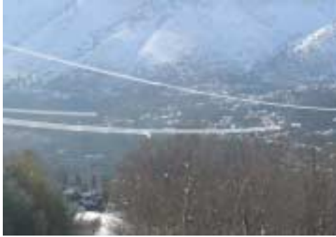
Φωτ. 1. Κεφαλονιά: Εναπομείναντες αγωγοί μετά τις ζημιές.
