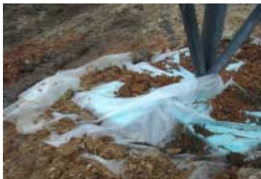
Φωτ. 11. Προστασία του σκυροδέματος των βάσεων με νάιλον και θερμομονωτικό υλικό.
