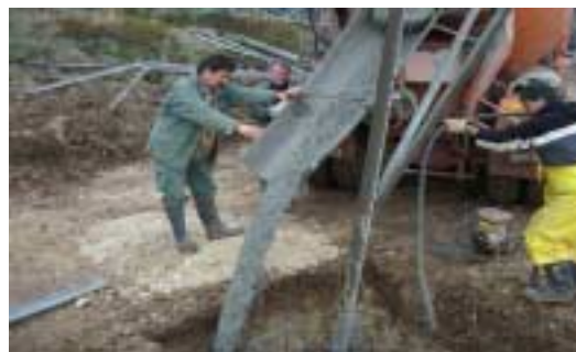
Φωτ. 6. Διαδικασία σκυροδέτησης. Διακρίνεται η μεγάλη ομοιογένεια-συνοχή του νωπού σκυροδέματος.
