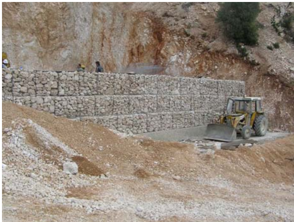
Φωτ. 11: Όψη οπλισμένου επιχώματος κατά τη διάρκεια της κατασκευής Picture 11: View of the reinforced embankment during construction
