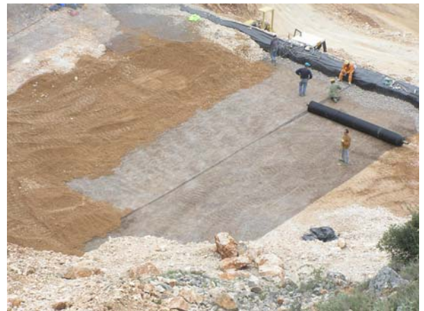
Φωτ. 10: Διάστρωση υλικού επίχωσης πάνω στον 2 ο γεωσυνθετικό οπλισμό Picture 10: Spreading of fill material over the 2 nd reinforcement strip
