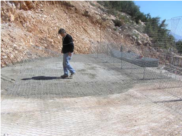
Φωτ. 4: Ειδικό συρματοκιβώτιο επένδυσης παρειάς του οπλισμένου επιχώματος Picture 4: Typical gabion unit used as facing element for the reinforced embankment
