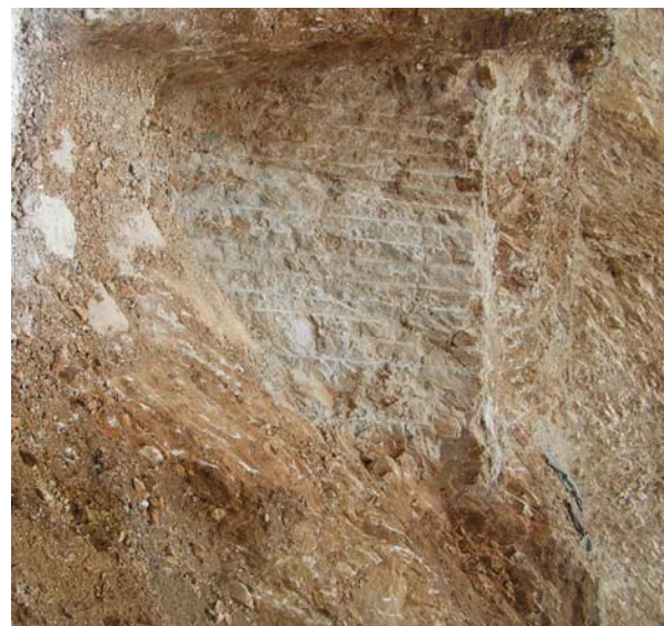
Φωτ. 3: Εκσκαφές αναβαθμών αγκύρωσης Picture 3: Slope cutting gradually conducted to ensure embankment anchorage
