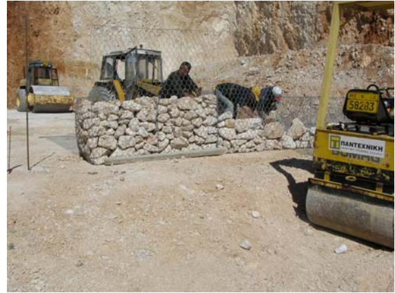
Φωτ. 5: Πλήρωση των ειδικών συρματοκιβωτίων με υγιείς λίθους Picture 5: Filling of the special gabion units with unweathered stones
