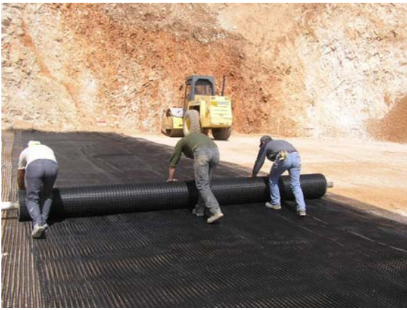
Φωτ. 7: Τοποθέτηση 1 ου γεωπλέγματος Picture 7: Installation of the 1 st geosynthetic reinforcement strip
