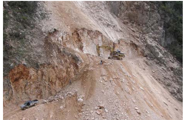
Φωτ. 2: Εκσκαφές για την κατασκευή του οπλισμένου επιχώματος Picture 2: Excavations for the construction of the reinforced embankment
