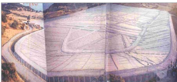
Φωτ. 1: Η Λ/Ξ έτοιμη με την μεμβράνη, τα «κομπολόγια» στα πρανή και το επίστρωμα πυθμένα.
