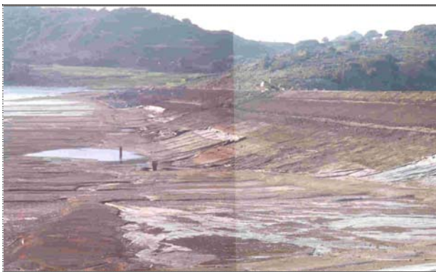
Φωτ. 4: Διαμόρφωση 2 αναβαθμών του υψηλού αναχώματος.
