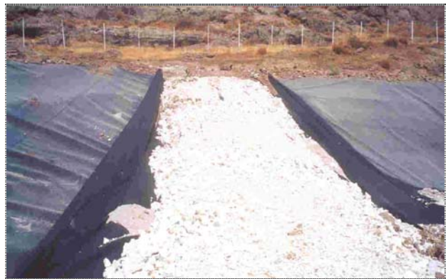
Φωτ. 5: Κατασκευή «Μαξιλαριού»
