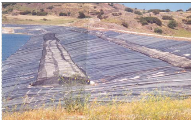
Φωτ. 7: Τελειωμένα «Μαξιλάρια» στους 2 Αναβαθμούς του υψηλού Αναχώματος
