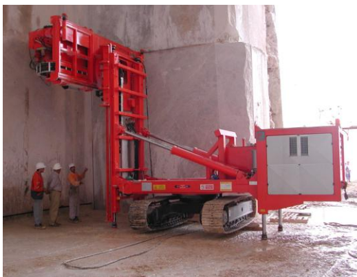
Εικόνα 2. Κοπή σκληρού πετρώματος με συρμάτινο διαμαντοκόφτη.
