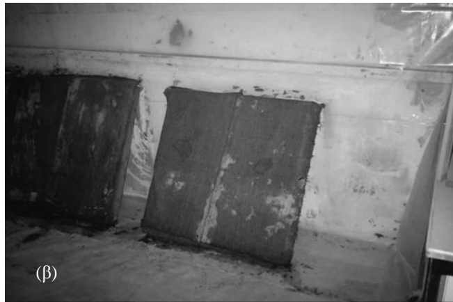
Σχήμα 1β : Συντήρηση του εκτοξευόμενου μετά τη διάστρωσή του
