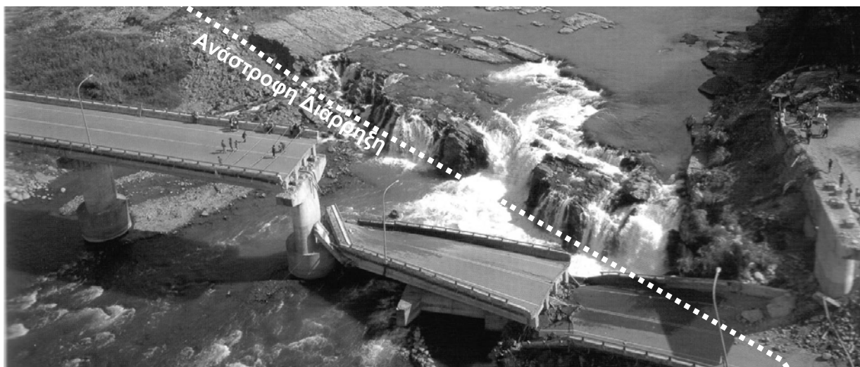
Σχήμα 1. Παράδειγμα αστοχίας γέφυρας λόγω ανάστροφης τεκτονικής διάρρηξης στον σεισμό Chi-Chi (Taiwan) του 1999 : πτώση δύο ανοιγμάτων της οδικής γέφυρας Bei-Fung [Hwang, 2000].
