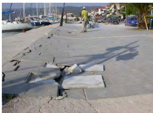
Σχήμα 5. Λευκάδα – Οδ. Γκολέμη: Βυθίσεις επίχωσης όπισθεν κρηπιδότοιχου
