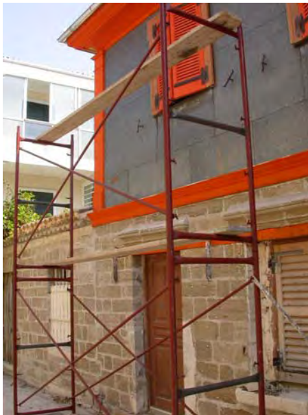
Σχήμα 14. Παραδοσιακό κτίριο της Λευκάδας με το διπλό δομικό σύστημα (λιθόκτιστο ισόγειο και πολυώροφος τριδιάστατος ξύλινος σκελετός κατάλληλα συνεργαζόμενος με το λιθόκτιστο ισόγειο).
