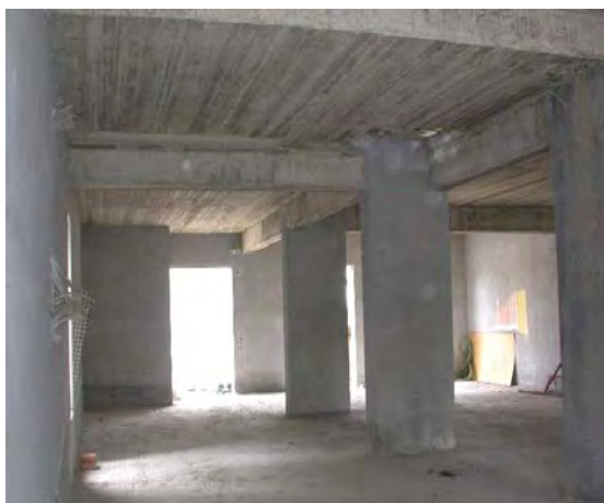
Σχήμα 26, 27. Εσωτερικό του κτιρίου του σχ.25, όπου φαίνεται η εκτεταμένη χρήση τοιχωμάτων ο/σ.
