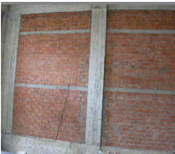
Σχήμα 32, 33. Υψηλή ποιότητα δόμησης τοιχοποιίας πλήρωσης στην Λευκάδα (κατασκ. 2003). Η υψηλή ποιότητα δόμησης δείχνει το υψηλό αίσθημα ευθύνης που διακατέχει τους εργατοτεχνίτες χτίστες της Λευκάδος (βλ. σχ.28-29).
