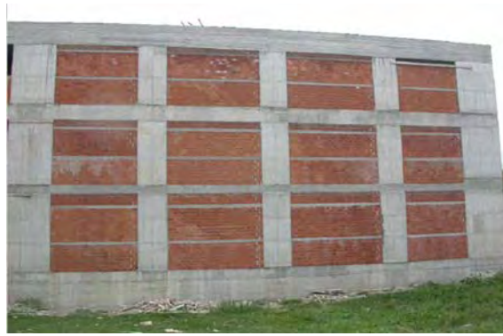
Σχήμα 28, 29. Κτίριο που το 2003 ήταν υπό κατασκευή. Φαίνεται η χρήση δύσκαμπτου σκελετού που συνδυάζεται με πολύ καλή πλινθόκτιστη τοιχοποιία μέσα σε περιβάλλον πλαίσιο ο/σ. Εδώ έχουμε συνδυασμό δύσκαμπτου σκελετού ο/σ με καλά δομημένη τοιχοποιία εντός του περιβάλλον πλαισίου (το ακριβώς αντίθετο από τις φωτογραφίες των σχ.16-19).
