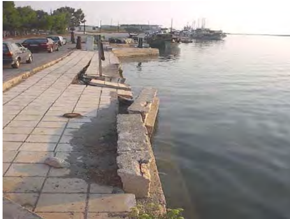
Σχήμα 9. Λευκάδα – Είσοδος (βορείως της πλωτής γέφυρας): Αστοχία κρηπιδώματος. Σχήμα 10. Νυδρί – Λιμένας: Ρευστοποίηση εδάφους με ανάδυση λεπτόκοκκου υλικού
