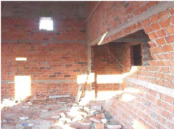
Σχήμα 18. Η εσωτερική τοιχοποιία αστόχησε ύστερα από έντονη ταλάντωση εκτός επιπέδου.
