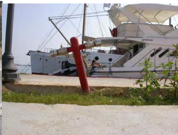
Σχήμα 11. Καλαμίτσι: Αστοχία οδοστρώματος από κατολίσθηση επί του οδικού άξονα Σχήμα 12. Λευκάδα – Μαρίνα. Μετακίνηση και στροφή του πυροσβεστικού κρουνού
