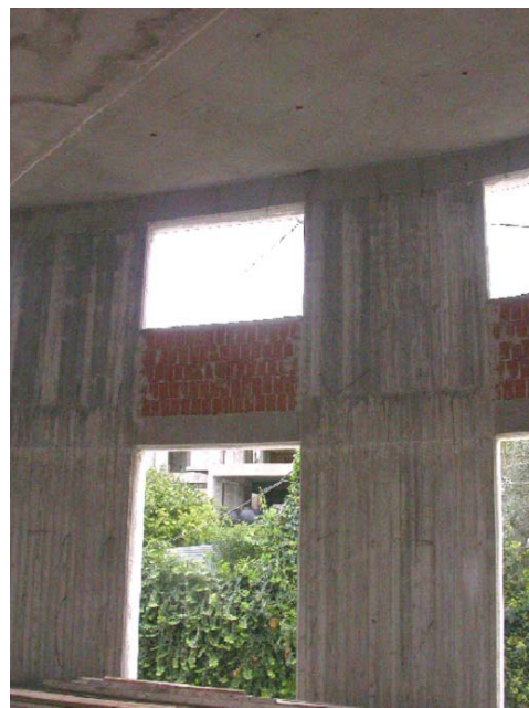
Σχήμα 30, 31. Χρήση δύσκαμπτου σκελετού με εκτεταμένη χρήση τοιχωμάτων ο/σ (βλ. σχ.28-29).
