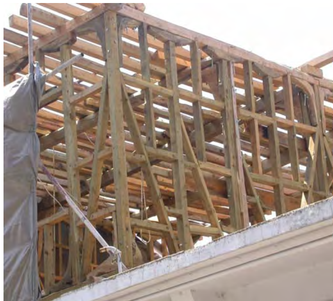
Σχήμα 14. Παραδοσιακό κτίριο της Λευκάδας με το διπλό δομικό σύστημα (λιθόκτιστο ισόγειο και πολυώροφος τριδιάστατος ξύλινος σκελετός κατάλληλα συνεργαζόμενος με το λιθόκτιστο ισόγειο).
