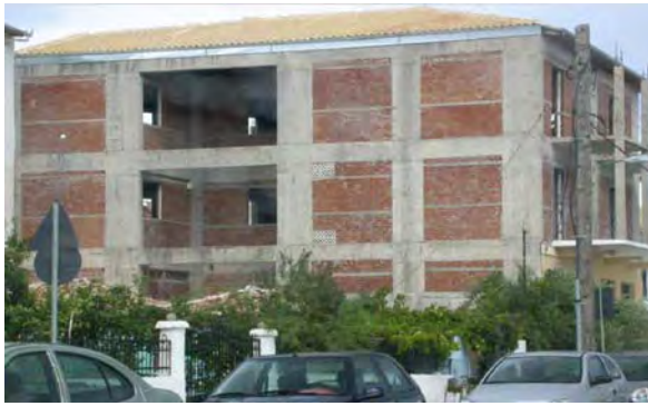
Σχήμα 28, 29. Κτίριο που το 2003 ήταν υπό κατασκευή. Φαίνεται η χρήση δύσκαμπτου σκελετού που συνδυάζεται με πολύ καλή πλινθόκτιστη τοιχοποιία μέσα σε περιβάλλον πλαίσιο ο/σ. Εδώ έχουμε συνδυασμό δύσκαμπτου σκελετού ο/σ με καλά δομημένη τοιχοποιία εντός του περιβάλλον πλαισίου (το ακριβώς αντίθετο από τις φωτογραφίες των σχ.16-19).
