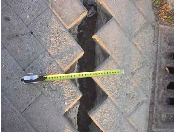
Σχήμα 7. Λευκάδα – Οδ. Σικελιανού: Οριζόντια μετακίνηση 10 όπισθεν του κρηπιδοτόιχου Σχήμα 8. Λευκάδα – Δίαυλος εισόδου: Καθιζήσεις επιχώματος κρηπιδοτόιχου
