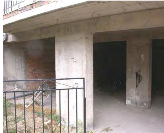
Σχήμα 22,23. Εσωτερικό της πωλητής του σχ.24 όπου φαίνεται η εκτεταμένη χρήση τοιχωμάτων ο/σ.
