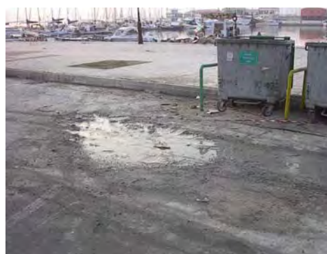
Σχήμα 5. Λευκάδα – Οδ. Γκολέμη: Βυθίσεις επίχωσης όπισθεν κρηπιδότοιχου
