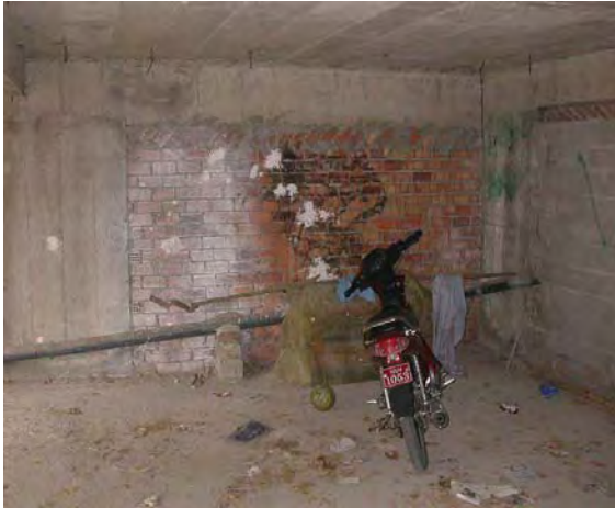
Σχήμα 22,23. Εσωτερικό της πωλητής του σχ.24 όπου φαίνεται η εκτεταμένη χρήση τοιχωμάτων ο/σ.
