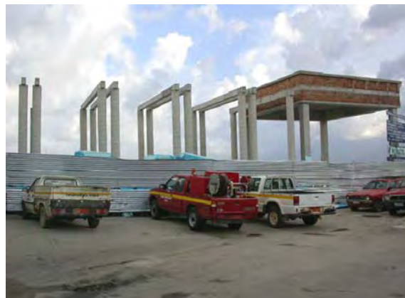
Σχήμα 18. Η εσωτερική τοιχοποιία αστόχησε ύστερα από έντονη ταλάντωση εκτός επιπέδου.
