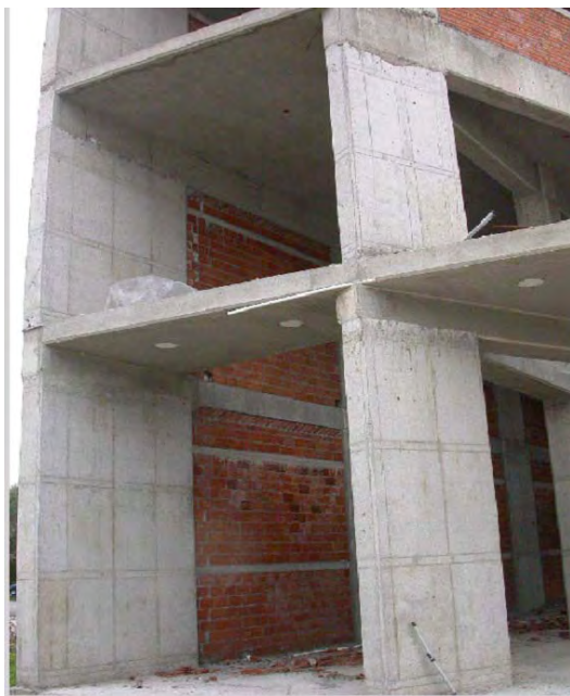
Σχήμα 30, 31. Χρήση δύσκαμπτου σκελετού με εκτεταμένη χρήση τοιχωμάτων ο/σ (βλ. σχ.28-29).
