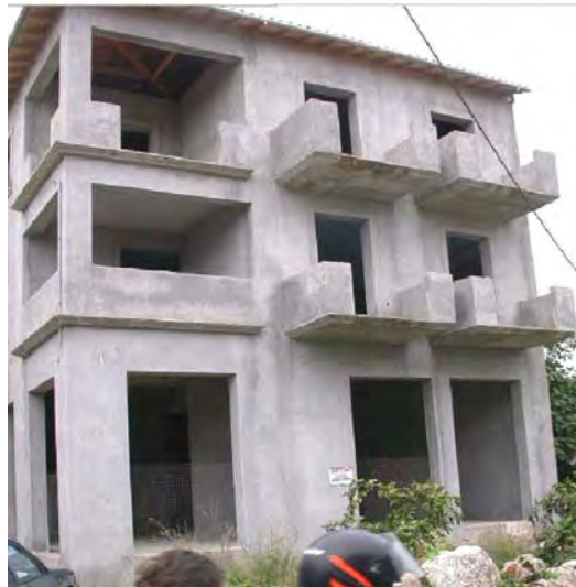
Σχήμα 24. 4-ώροφο (1984) με πωλητή δεν εμφανίσε βλάβη λόγω εκτεταμένης χρήσης τοιχωμάτων. Σχήμα 25. Νεόκτιστο 3-ώροφο (2003), δεν εμφανίσε βλάβη λόγω εκτεταμένης χρήσης τοιχωμάτων.
