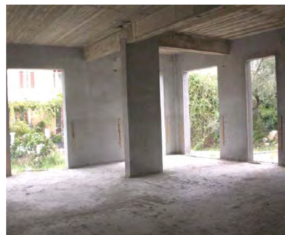
Σχήμα 26, 27. Εσωτερικό του κτιρίου του σχ.25, όπου φαίνεται η εκτεταμένη χρήση τοιχωμάτων ο/σ.
