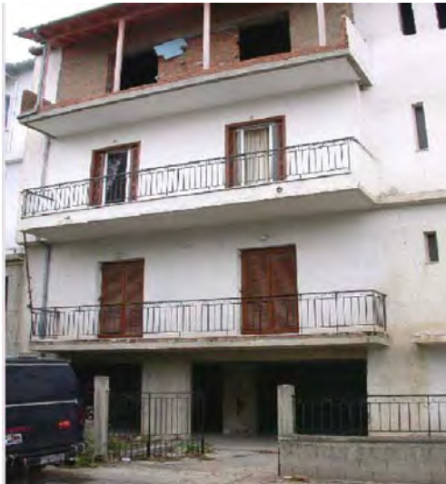
Σχήμα 24. 4-ώροφο (1984) με πωλητή δεν εμφανίσε βλάβη λόγω εκτεταμένης χρήσης τοιχωμάτων. Σχήμα 25. Νεόκτιστο 3-ώροφο (2003), δεν εμφανίσε βλάβη λόγω εκτεταμένης χρήσης τοιχωμάτων.
