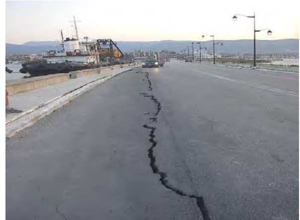
Σχήμα 7. Λευκάδα – Οδ. Σικελιανού: Οριζόντια μετακίνηση 10 όπισθεν του κρηπιδοτόιχου Σχήμα 8. Λευκάδα – Δίαυλος εισόδου: Καθιζήσεις επιχώματος κρηπιδοτόιχου
