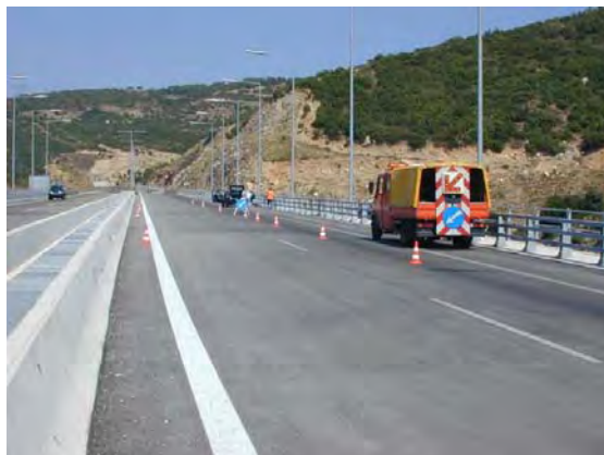
Σχήμα 6. Μέτρα ασφαλείας κατά τη διάρκεια των εργασιών στη γέφυρα.
