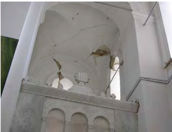
Σχήμα 8. Εκτεταμένες βλάβες στο σταυροθόλιο και στα τόξα στον Ι.Ν. Αγ. Τριάδος στα Μητάτα.
