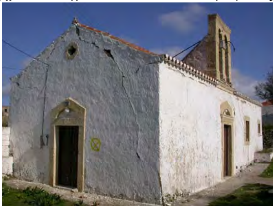
Σχήμα 10. Αστοχία του τύμπανου του λιθόκτιστου Ι.Ν. Αγ.Γεωργίου στα Μητάτα. Η ιστορική κατακόμβη του ναού δεν παρουσίασε βλάβες.
