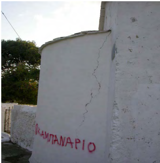
Σχήμα 14. Ρωγή στην ανατολική κόγχη στον Ι.Ν. Αγ. Αναργύρων στον οικισμό Ποταμό
