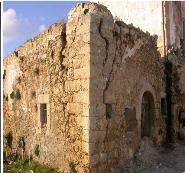
Σχήμα 4. Ρηγματώσεις σε διώροφο λιθόκτιστο κτίριο στον οικισμό Ποταμό.
