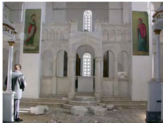
Σχήμα 8. Εκτεταμένες βλάβες στο σταυροθόλιο και στα τόξα στον Ι.Ν. Αγ. Τριάδος στα Μητάτα.
