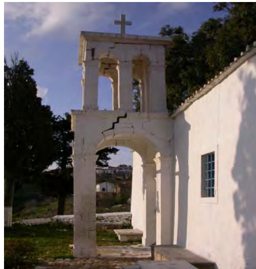
Σχήμα 14. Ρωγή στην ανατολική κόγχη στον Ι.Ν. Αγ. Αναργύρων στον οικισμό Ποταμό
