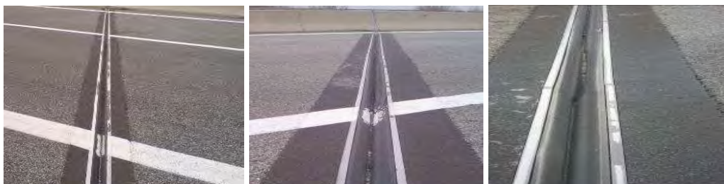
Σχήμα 7. Αρμός αγκυρούμενος (σφηνωτός) και ένδειξη (δεξιά) τοπικής αποσύνδεσης.
