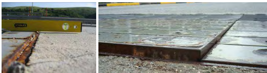
Σχήμα 6. Βλάβες αρμών με μεταλλική κάλυψη διακένου.
