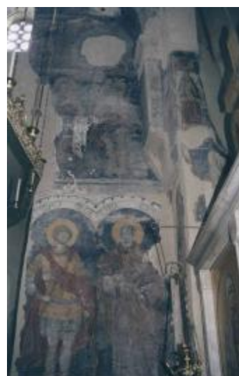
Εικόνα 4: αποσάθρωση χρωματικής επιφάνειας
