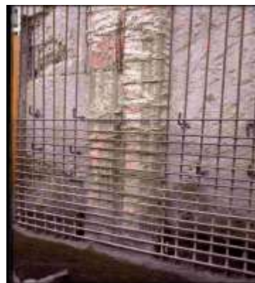
Σχήμα 7. Επεμβάσεις ενίσχυσης. Αριστερά: ντίζες σύνδεσης εσωτερικών ιοχωμάτων παράλληλων στον αρμό. Δεξιά άνω: ζώνη ΟΣ ιπαστί του αρμού στο δώμα. Δεξιά κάτω: Ενίσχυση/ενοποίηση κάθετων στον αρμό εξωτερικών ιοχωμάτων.
