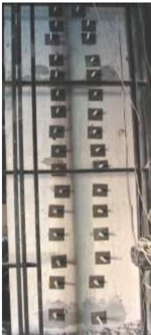
Σχήμα 7. Επεμβάσεις ενίσχυσης. Αριστερά: ντίζες σύνδεσης εσωτερικών ιοχωμάτων παράλληλων στον αρμό. Δεξιά άνω: ζώνη ΟΣ ιπαστί του αρμού στο δώμα. Δεξιά κάτω: Ενίσχυση/ενοποίηση κάθετων στον αρμό εξωτερικών ιοχωμάτων.
