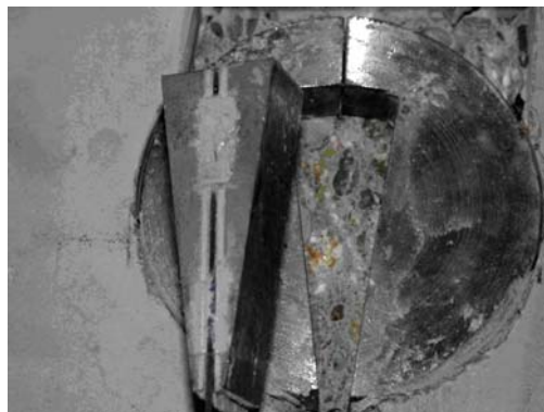
Σχήμα 3. Το σύστημα αγκύρωσης ανθρακοελασμάτων “CARBON ANCHOR”
