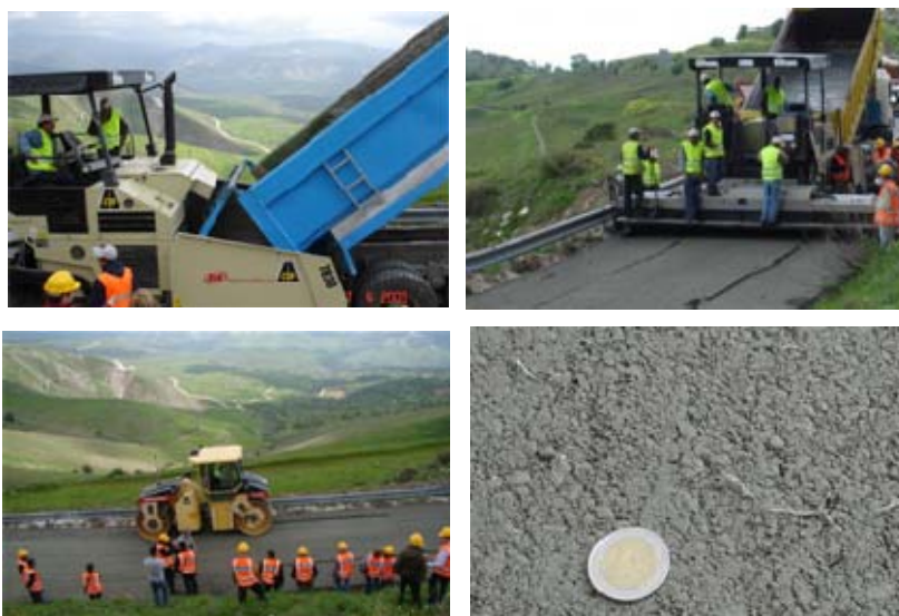
Σχήμα 9. Κατασκευή πιλοτικού οδοστρώματος ΙΚΣ στην Γαλαταριά
