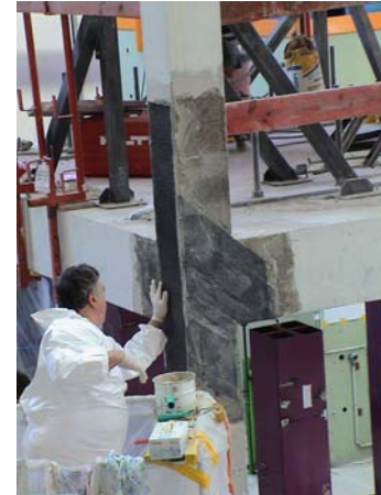
Σχήμα 4. Τοποθέτηση των διαγώνιων υφασμάτων
