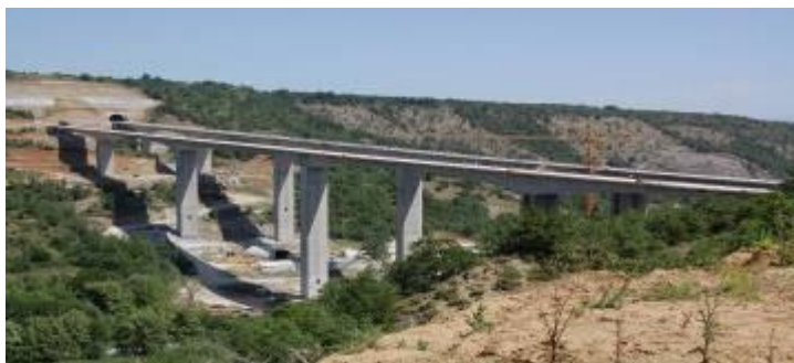
Σχήμα 3. Άποψη της γέφυρας
