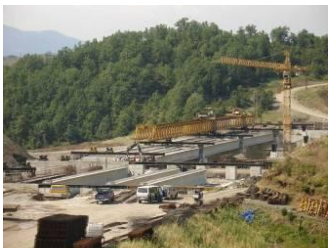
Σχήμα 6. Φορείο καθέλκυσης δοκών μήκους 112μ.
