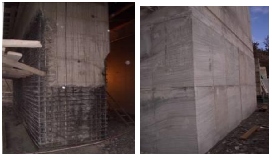
Σχήμα 9. Αποκάλυψη σπλισμών με την υδροβολή (αρ.), Αποκατάσταση διατομής (δεξιά)
