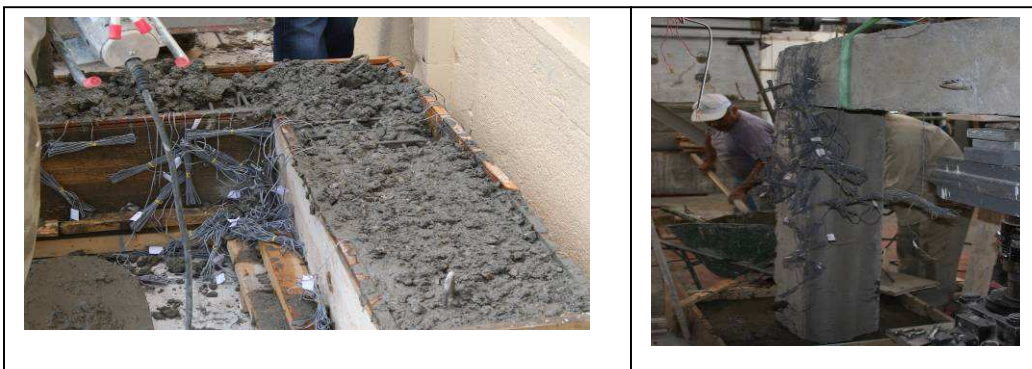
Σχήμα 2 Σκυροδέτηση δοκιμίου και βάσης
