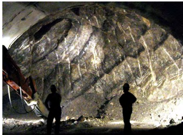
Σχήμα 11. Η βραχομάζα στο μέτωπο της σήραγγας κατά την διάνοιξη. Figure 11. The rock mass at tunnel face.
