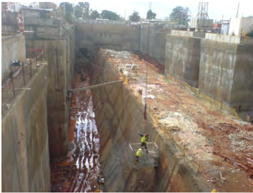
Φωτογραφία 1: Άποψη πρίσματος Photograph 1: Prism view
