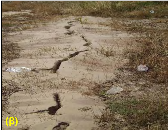
Σχήμα 3. Κρατήρες άμμου στη παραλιακή ζώνη της Κ. Αχαΐας μετά το σεισμό της 8-6-2008.
