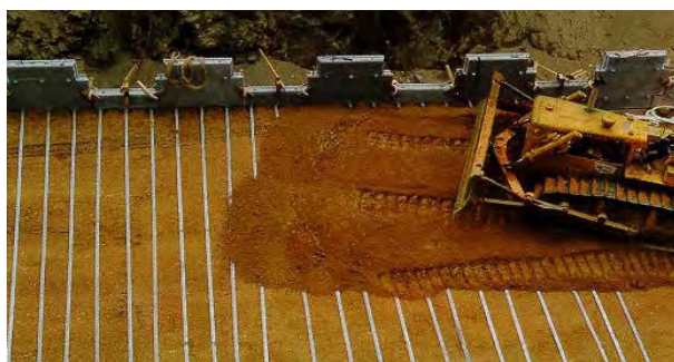
Σχήμα 1. Κατασκευή τοίχου αντιστήριξης από ωπλισμένη γη
