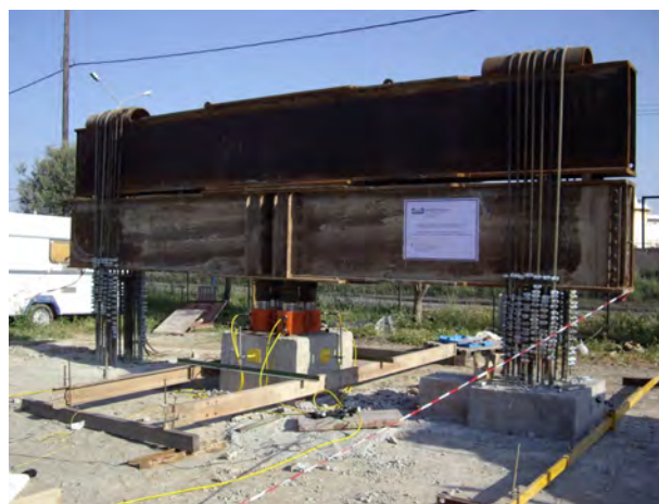
Φωτογραφία 1. Απεικόνιση δοκιμαστικής φόρτισης Photograph 1. Illustration of pile test setup
