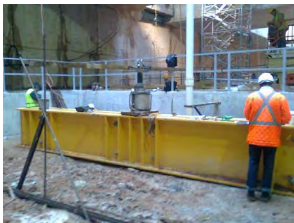
Φωτογραφία 1. Διάταξη δοκιμαστικής φόρτισης μικροπασσάλων σε εφελκυσμό Photograph 1: Set-up of micropile tension load test
