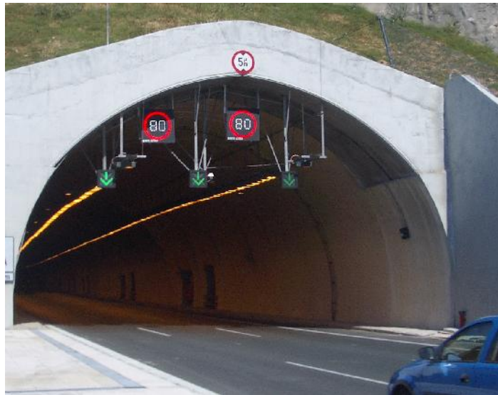
Σχήμα 6. Αντιπαράδειγμα τοποθέτησης Πινακίδων μεταβλητής ένδειξης σε γέφυρα σήμανσης πάνω από τρεις λωρίδες κυκλοφορίας
