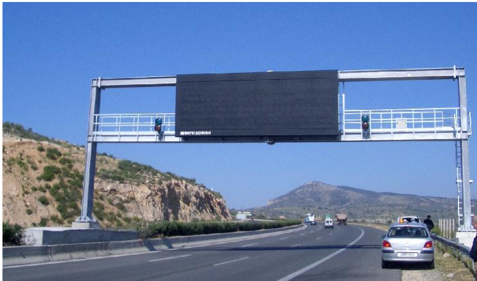
Σχήμα 9. Πινακίδα αναγγελίας πληροφοριών με δυνατότητα απεικόνισης μόνον αλφαριθμητικών χαρακτήρων σε τέσσερις γραμμές χωρίς κυκλοφοριακό σήμα – Δεξιά και αριστερά της πινακίδας σηματοδότες – Λάθος
