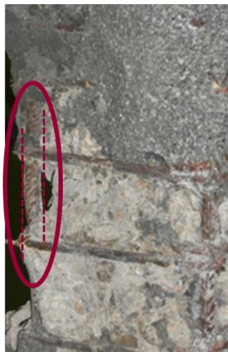
Σχήμα 4: Λυγισμός διαμήκους ράβδου οπλισμού
