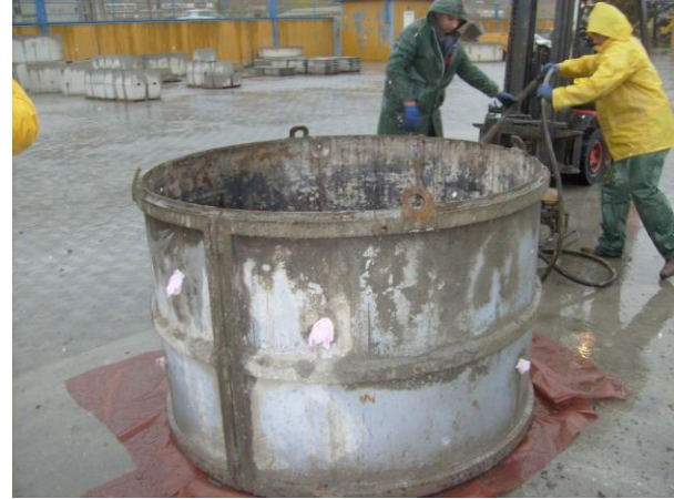
Σχ. 5 Καλούπι για τη σκυροδέτηση ογκόλιθου
