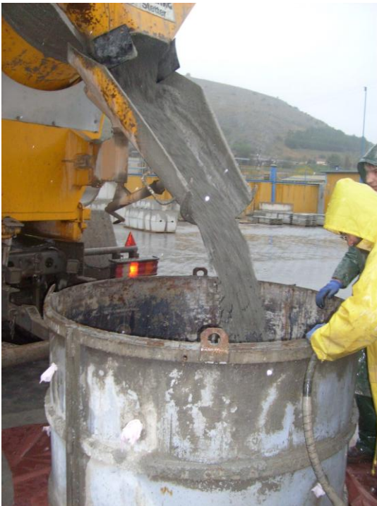
Σχ. 6 Εκφόρτωση του νωπού σκυροδέματος στο καλούπι
