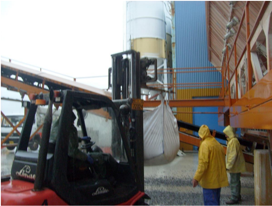
Σχ. 1 Φόρτωση των αδρανών στον ταινιόδρομο
