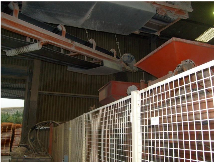
Φωτ.5 Μεταφορά των υλικών στον κάδο ανάμιξης
