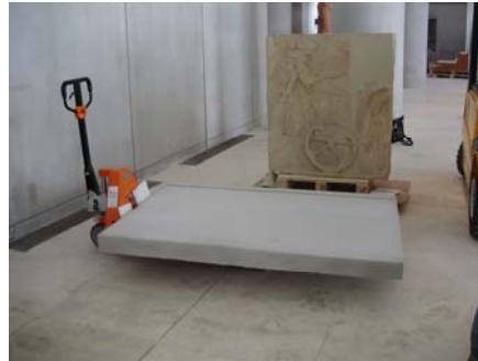
Σχ. 7. & 8. Αποθήκευση και μεταφορά προκατασκευασμένων βάθρων αγαλμάτων Νέου Μουσείου Ακρόπολης (ΠΡΟΕΤ ΑΕ 2008)
