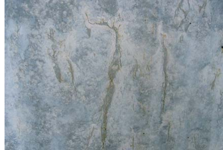
Σχ. 6. Διαφορά αποχρώσεων λόγω εσφαλμένου αποκαλουπωτικού υλικού.
