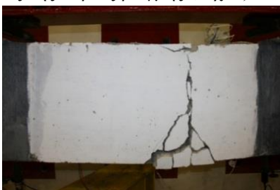
Σχ. 3 Όψη ανοίγματος της δοκού REX20-H έπειτα από αστοχία του χάλυβα σε κόπωση
