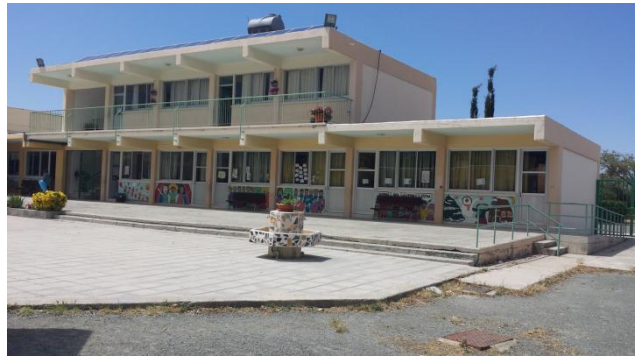
Εικ. 2 Βόρεια Πτέρυγα Β΄ Δημοτικού Σχολείου Πέρα Χωρίου Νήσου
