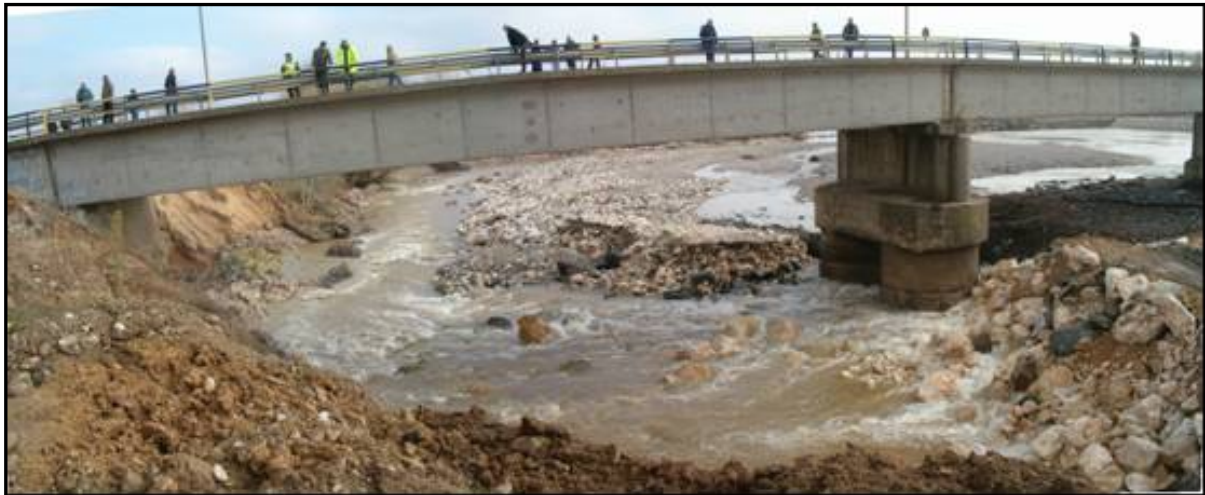
Φωτογραφία 2: Νοέμβριος 2007, υποσκαφή κοίτης στο 1 ο φάτνωμα.
