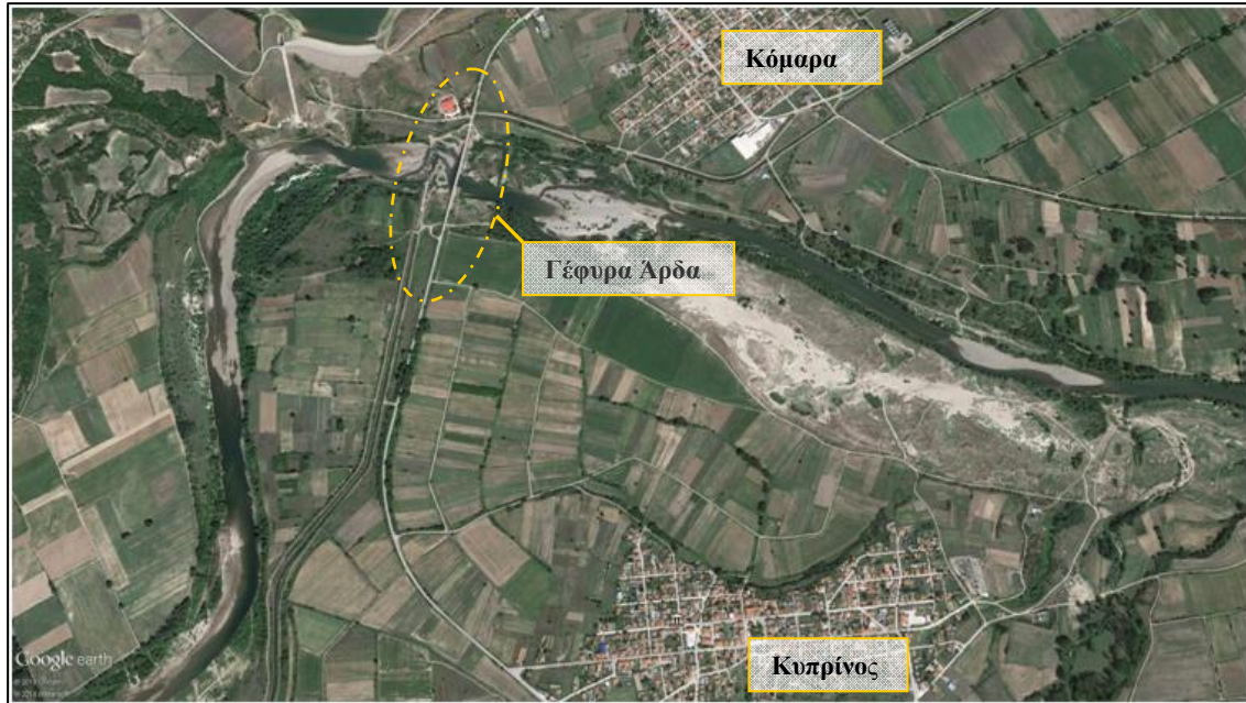
Φωτογραφία 1: Η γέφυρα Άρδα μεταξύ των οικισμών Κυπρίνου και Κομάρων Έβρου.
