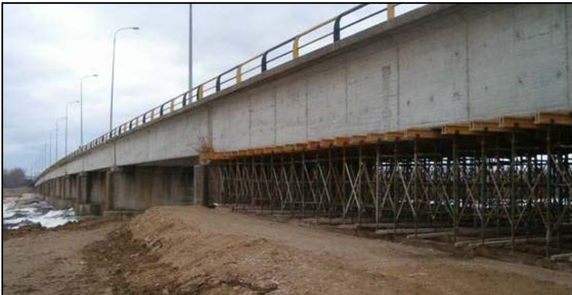
Φωτογραφία 4: Υποστύλωση προβληματικού φατνώματος.
