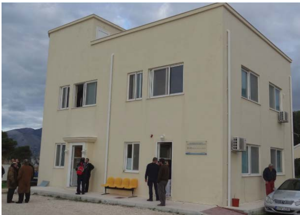
Σχ. 1 Κτίριο Διοίκησης του Νοσοκομείου Ληξουρίου
